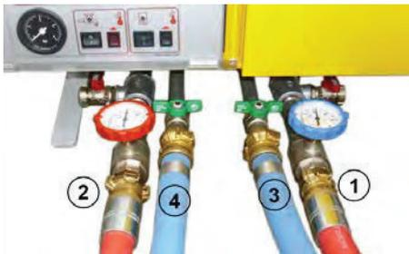
**Bild:** Kugelhähne mit Thermometergriff schließen
