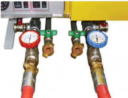
*Bild: Kugelhähne mit Thermometergriff schließen*
