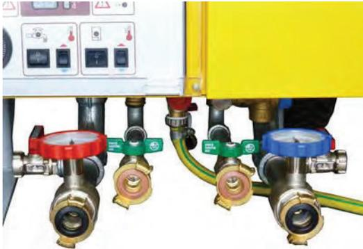
**Bild:** Entleer-Kugelhahn öffnen und Wasser ablassen
