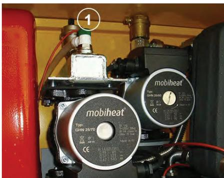
**Bild:** Rücklauf-Schraubkappe schließen
