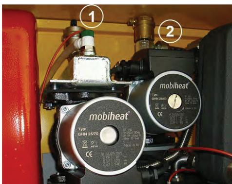
**Bild:** Entlüftungsschraube schließen
