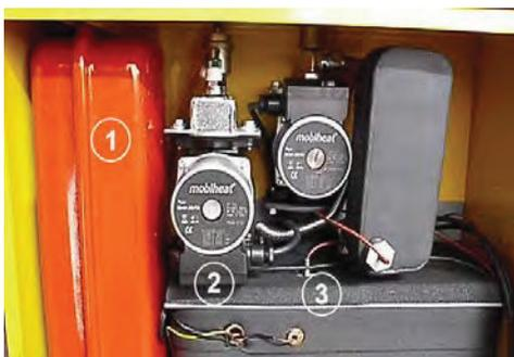
**Bild:** Innenansicht, MAG, Sicherheitstemperaturbegrenzer, Luftfühler
