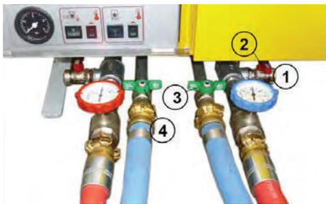
**Bild:** Entlüftungsschraube öffnen
