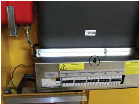
**Bild:** Schutzabdeckung und Fehlerstrom-Schutzschalter (FI / RCD)
